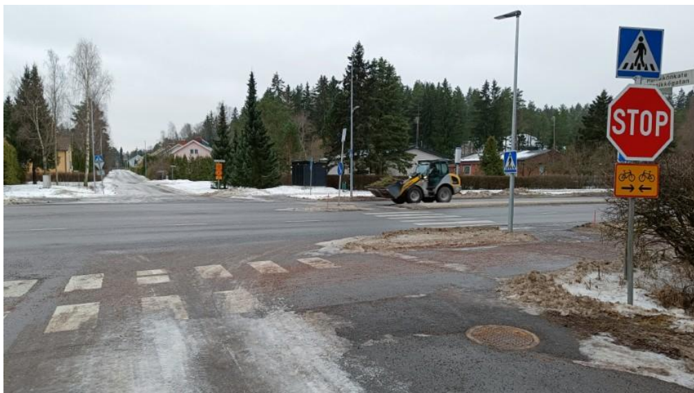
Kuva 2 Pohjoispuoli STOP-merkin takaa. Auto peittää kevyenliikenteen väylän STOP-merkin takaa. Autoilija näkee väylällä lähestyvät vasta ajettuaan väylän päälle. Tilanne on erityisen vaarallinen pyöräilijöille ja sähköskuutilla liikkujille. Katvealue ja vilkas liikenne lisäävät onnettomuusriskiä koululaisille ja jalankulkijoille.
