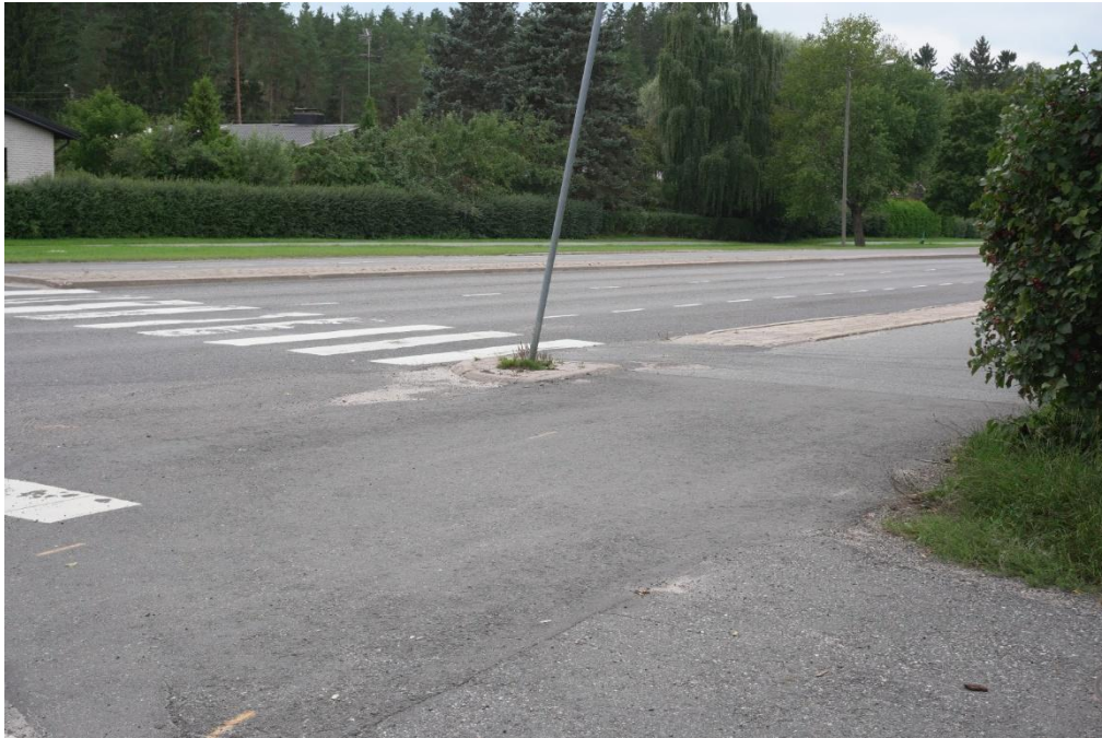
Kuva 5 Pohjoispuoli kesäaikaan, näkyvyys suojatielle ja väylälle. Kuva osoittaa, että pohjoisen suunnasta saapuva autoilija saa näkyvyyden suojatielle ja pyöräilyväylälle vasta edettyään pitkälle risteysalueelle. Ajoinmuoto ja kasvillisuus luovat katveen, jonka vuoksi kuljettajan on käytännössä pakko ajaa syvälle väylän puolelle ennen näkymän avautumista. Tämä lisää selvästi konfliktitilanteita kevyen liikenteen kanssa.
